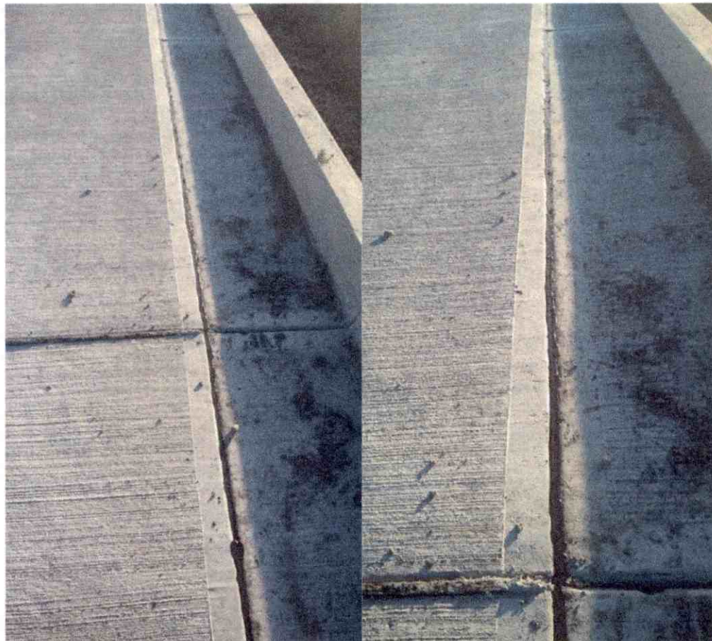
DURANTE EL PROCESO DE LA OBRA
