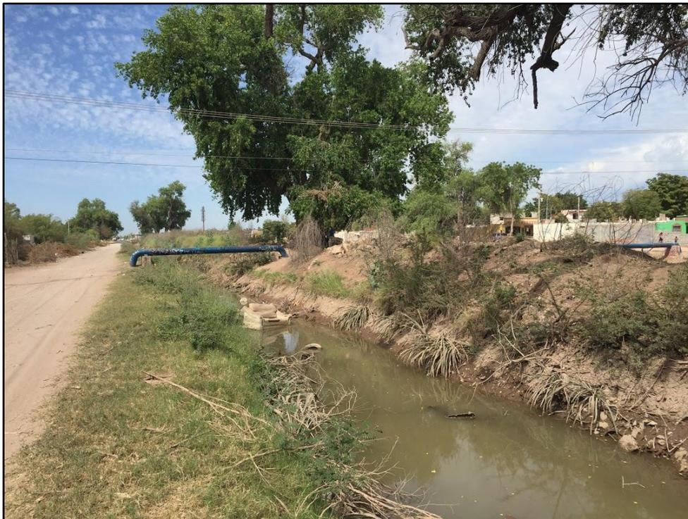
**Imagen 4: Canal ramal 5+700 y bypass de agua potable en cruce con calle Mariano Escobedo (se observa nivel de azolvamiento y maleza que crece en los bordos del canal)**
